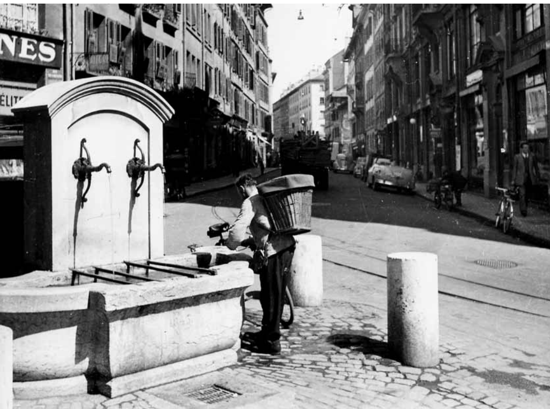
Fontaine du haut de Coutance, dessinée par l'ingénieur Christian Wolfsberger en 1844 et mise en eau la même année. La fontaine de 4 e classe de Saint-Gervais est devenue une fontaine à double bec; elle a joué en duo jusqu'en 1949, le bassin seul est réapparu place Simon-Goulard. Photographie de 1949, coll. part.
