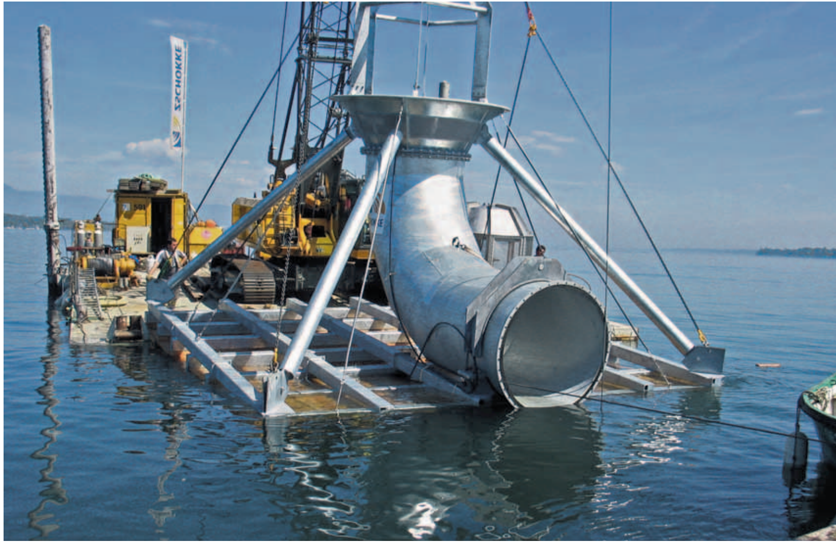
La crépine SIG juste avant d'être déposée dans le lit du petit lac à 45 mètres de profondeur.
